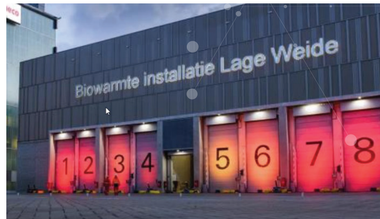
BioWarmte Installatie Lage Weide(BWI), Netherlands
